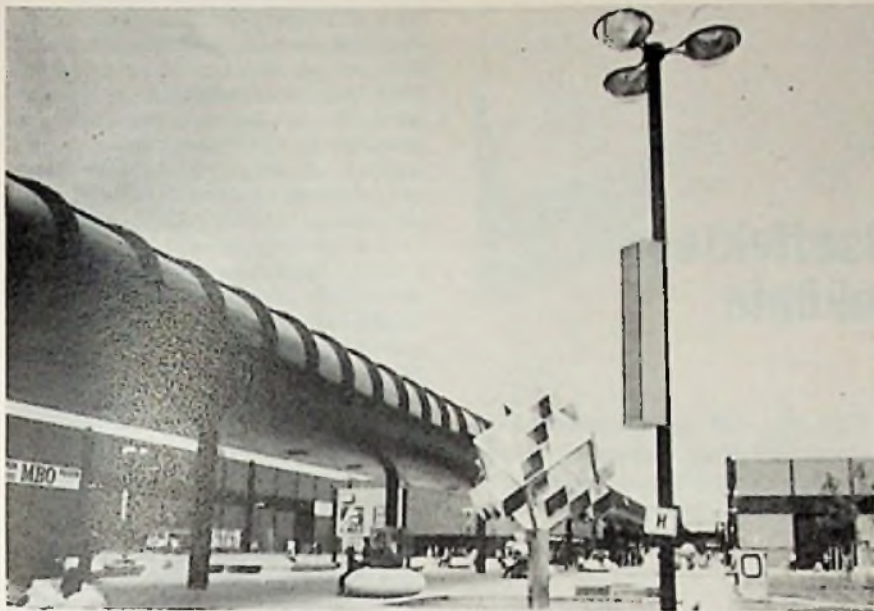
Bild 10. Freiflächenbeschallung mit Tonstrahlern
