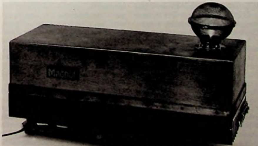
Prototyp des Korona-Plasma-Lautsprechers (Magnat)
