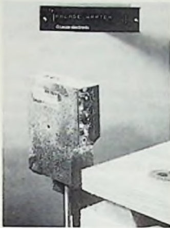
Bild 1: Reflexlichtschranke mit optischer Fehlermeldung (Leuze-Pressbild)
