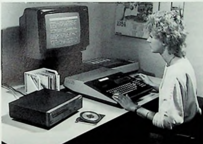
Bild 1: CD-ROM mit 600 Mbit Speicherkapazität (Philips-Pressebild)
