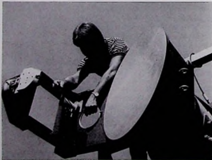
Bild 1: Einbau eines Ringrillenerregers in die Kopernikus-Antenne (ANT-Pressbild)
