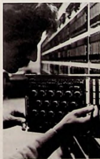
Bild 1: Prüfarbeiten in einer Ortsvermittlungsstelle SYSTEM 12, dem Vorgänger des Systems 2000 (Foto: SEL)
