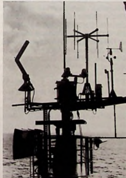
Bild 2: Spitze des Antennenmastes der Forschungsplattform „Nordsee“ mit Peilantennensystem des VHF-Doppler-Peilers PA 022 von Rohde & Schwarz (Fotos: Abich)
