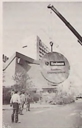
Bild 1: Montage der Satelliten-Empfangsantenne (Hirschmann-Pressesbild)
