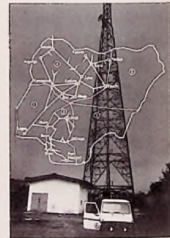
Bild 1: Bis zu 140 m hoch sind die Stahltürme für die Richtfunkstrecken in Nigeria (Siemens-Pressbild)
