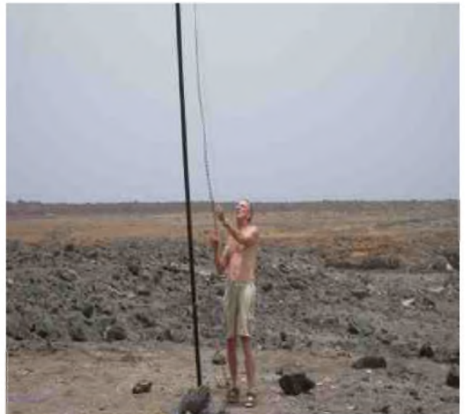
D44TOI, montage d'antenne OC
