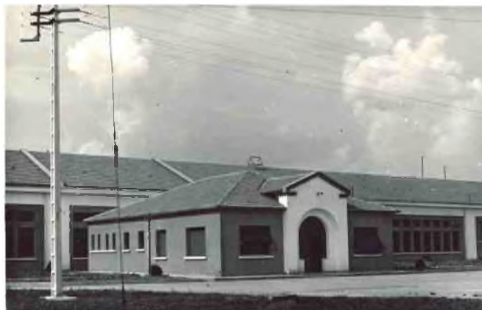
Centre Emetteur du Vernet. Bâtiment d'émission E2
