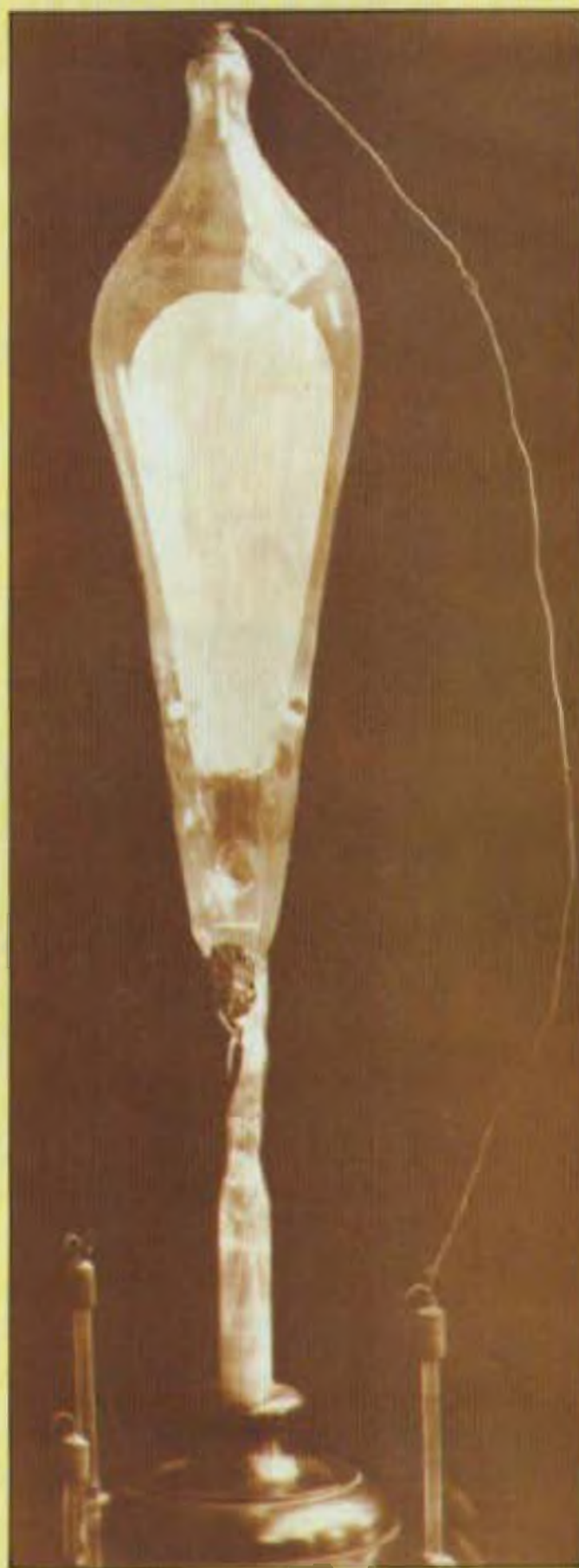
Tube de William Crookes pour l'étude des effets de décharges électriques.
