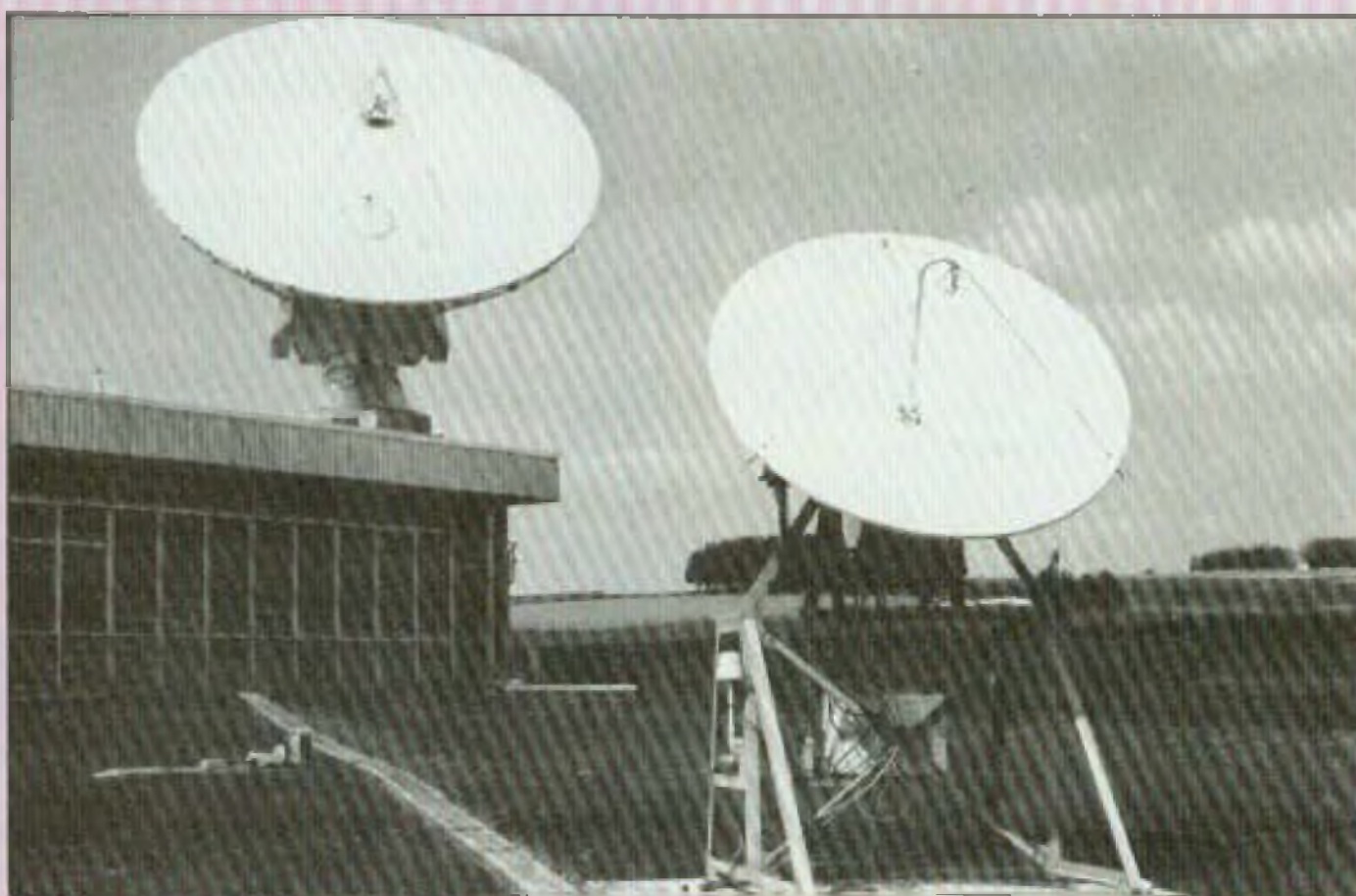
Station de contrôle d'ECS. Radu, Belgique.
