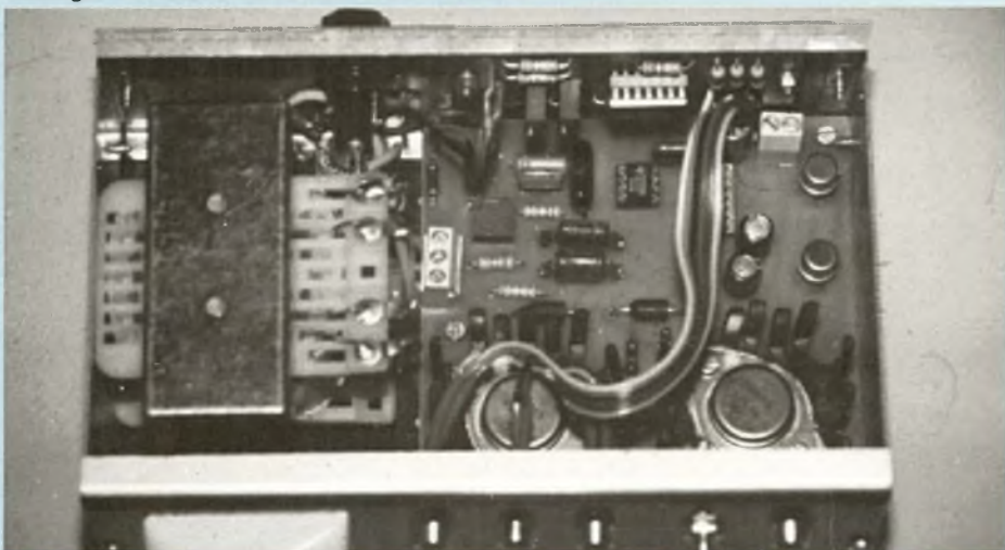
Vue intérieure du coffret, réalisation terminée.
