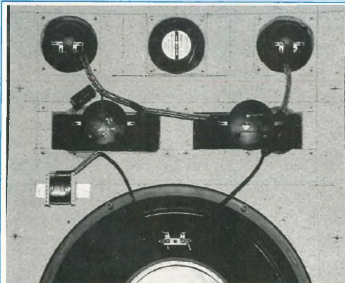
Précâblage du panneau avant : les éléments du filtre sont fixés directement sur le panneau frontal. Notez la mise en œuvre d'une gaine spirale pour le maintien des câbles : la fiabilité des connexions s'en trouve considérablement accrue !
