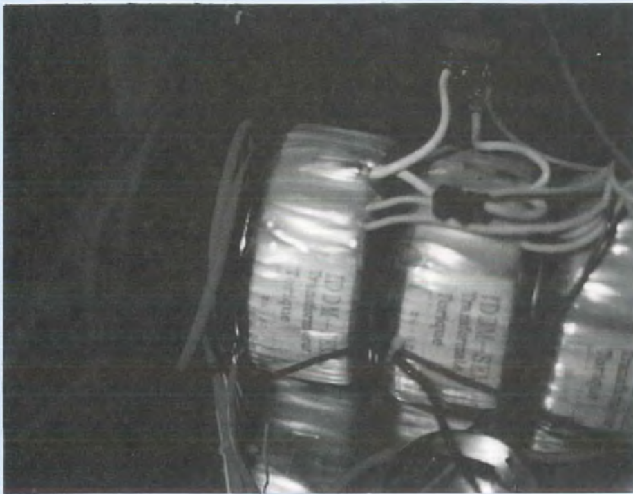
Photo 9 : montage du blindé d'entrée par rapport aux transformateurs
