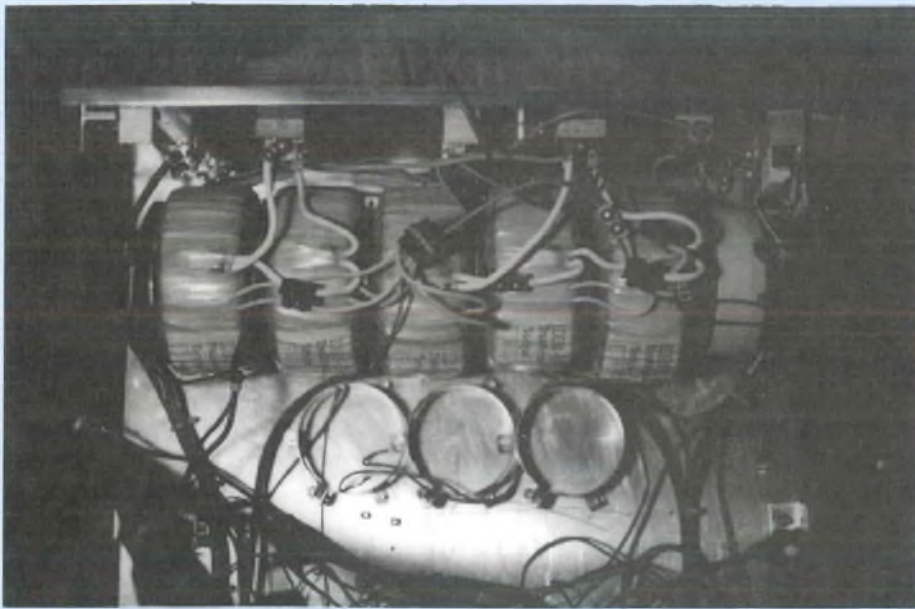
Photo 3 : vue intérieure de la face arrière
