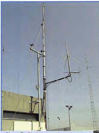
Photo 5 - Girouette, anémomètre, pluviomètre et antennes packet-radio.
