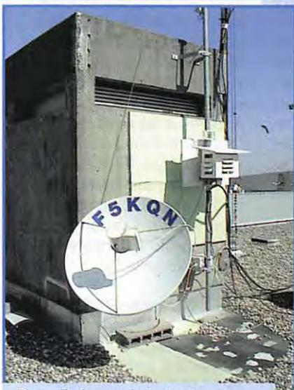
Photo 7 - La parabole de réception Meteosat et la station de mesures météo.
