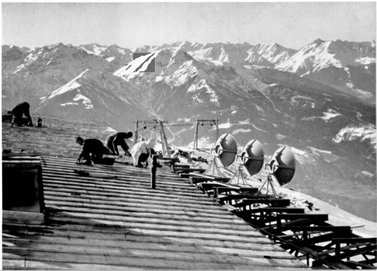
Große Anforderungen an Mensch und Material stellt das Bauen im Hochgebirge. Das Bild zeigt die Dacheindeckung des Sendergebäudes Patscherkofel (2247 m).
