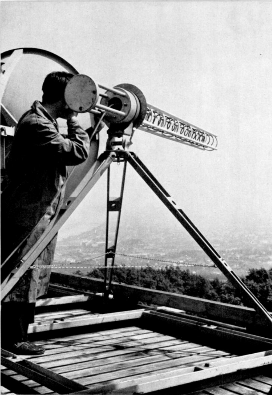
Richtfunkgeräte stellen die Verbindung zwischen Aufnahmeort und Studio her. Das Bild zeigt die Einstellung eines der Geräte auf dem Kahlenberg.
