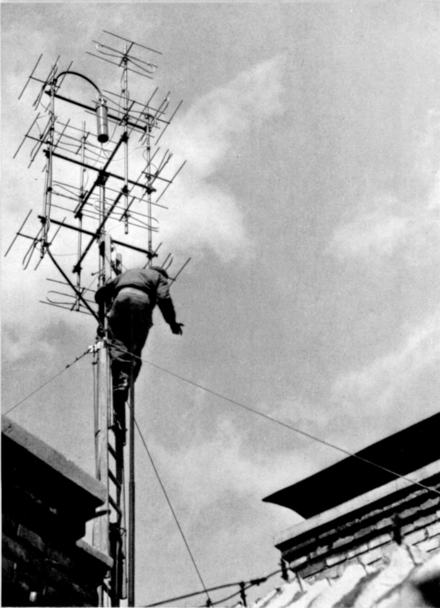
Die Antenne des ersten Fernsehsenders des Österreichischen Rundfunks, errichtet Anfang 1955 in Wien XII.
