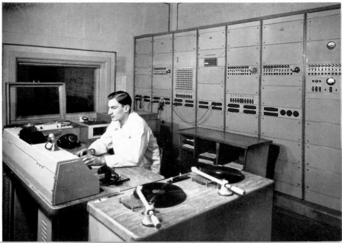
Funkhaus Klagenfurt — Regieraum mit Schalt- und Kontrollgeräten.
