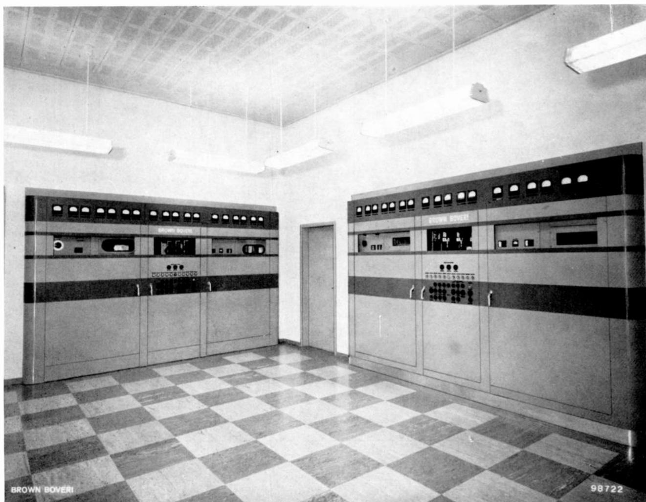
Sendesaal der Sendeanlage Klagenfurt mit zwei 25 kW-Mittelwellensendern
