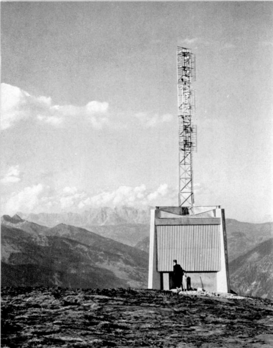
Für die Rundfunkhörer des Gasteiner Tales wurde auf dem 2237 m hohen Stubnerkogel im Jahre 1957 eine Sendestation erbaut. Sie ist die erste Anlage des Österreichischen Rundfunks, die für die Ausstrahlung aller drei Programme eingerichtet ist. Das Sendergebäude ist zugleich Mastfundament.
