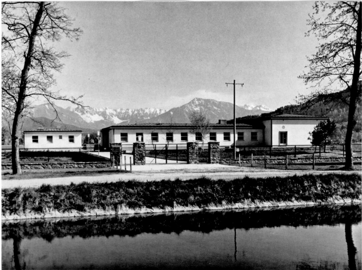
Die Senderanlage Klagenfurt wurde in den Jahren 1953/54 erbaut. Sie enthält je einen 25-Kilowatt-Sender für das Kärntner Regionalprogramm und für das „Zweite Programm“.
