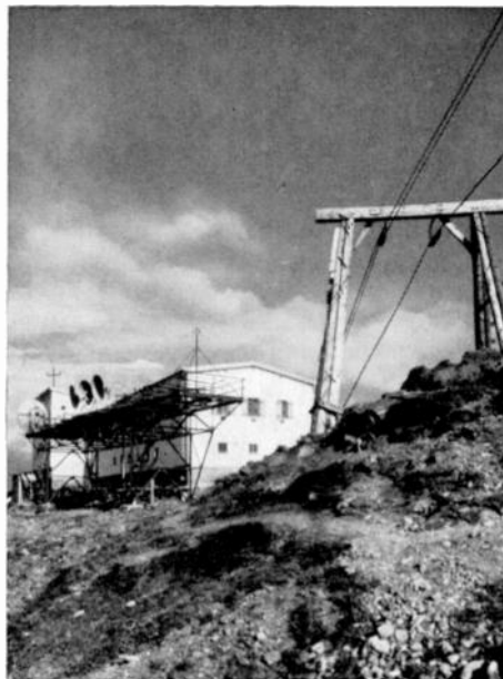
Der UKW-Sender „Patscherkofel“ (2245 m), Rohbau- erstellung 92 Arbeitstage
