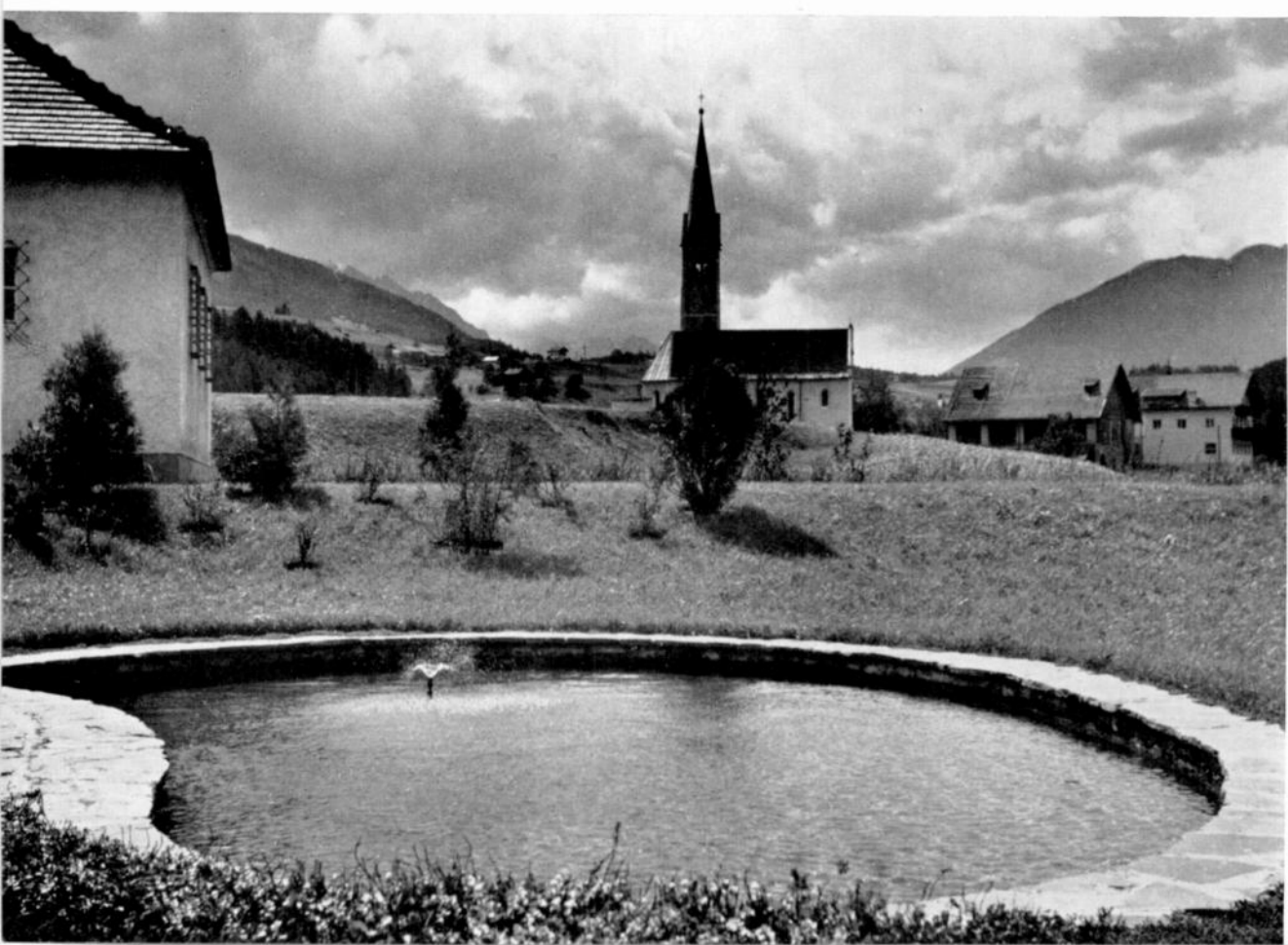
Teil des Erweiterungsbaues und Gartenanlage der Sendestation Aldrans.
