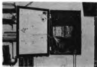
Figura 5 - Il pannello degli indicatori visivi è montato su cerniera, per facilitare l'accesso alle unità logiche e alle interfacce.
