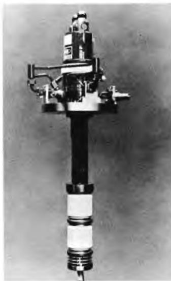
Il nuovo tubo a cavità accoppiate, denominato VTA-5700, permette ora ai progettisti di avere a disposizione una sorgente ad alta potenza per lo sviluppo di sistemi a radar millimetrico con maggiore risoluzione. Più specificatamente, il VTA-5700 è progettato per operare a 35 GHz e fornisce oltre 30 Kilowatts (kW) di potenza massima in uscita, a 9 kW di potenza media e con una durata d'impulso di 300 microsecondi (µsec). Tali prestazioni sono 10 volte supe-
