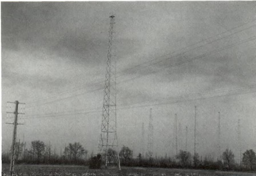
Les antennes de Saint-Lys radio
