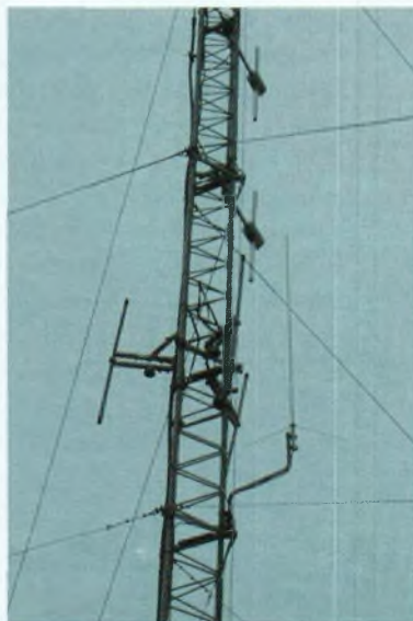
Le relais Montparnasse : Notez le couplage des deux dipôles verticaux.
