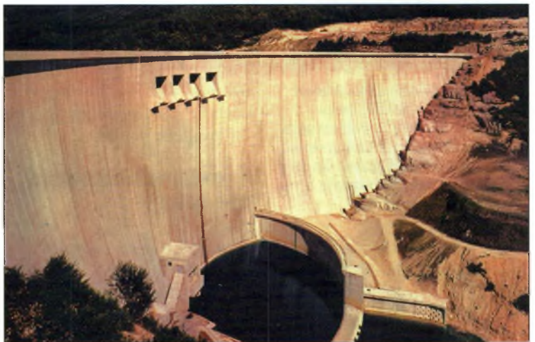
Le principe de la pile peut être comparé à celui d'un barrage, sa différence de potentiel (la tension) est l'eau du barrage.
