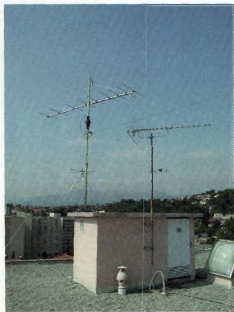
L'antenne montée sur son mât avec du tube de diamètre 50 millimètres. On distingue par ailleurs une discone, une filaire (DDK20), un moteur G800SDX et un bout de l'antenne TV de l'immeuble.
