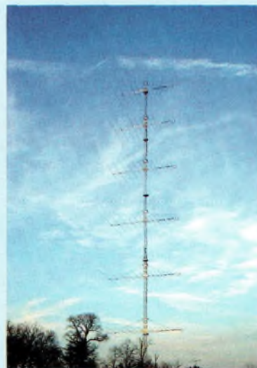
6 log-périodique 16 éléments HF stackées...
