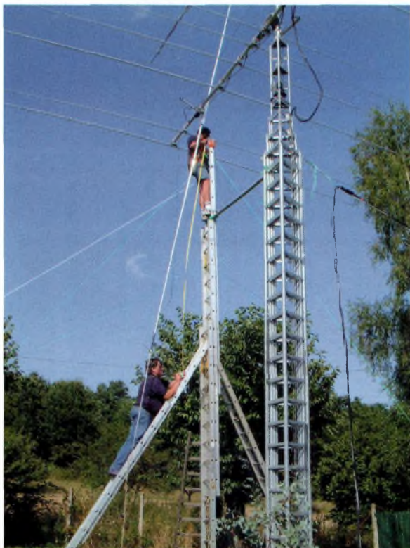
Une situation bien périlleuse pour Philippe, F4BTP.
