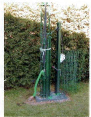
La base d'un pylône de fabrication personnelle.
