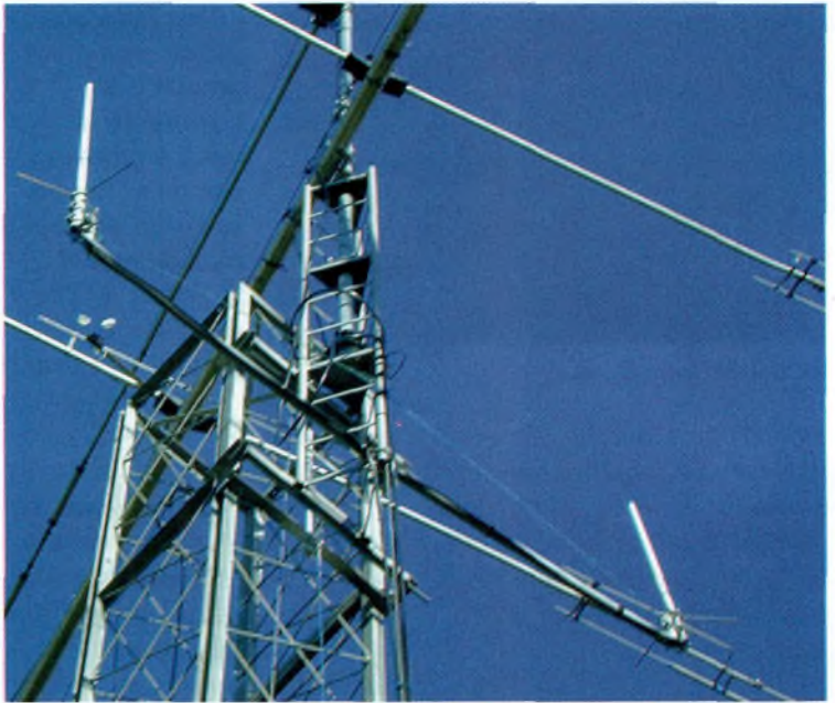
Egalement 3 verticales V/U qui servent pour le packet, l'après, le cluster, ainsi que le réseau DX local " 145 237.5 " qrg sur lequel ils se retrouvent à une dizaine de DX'man pour discuter.
