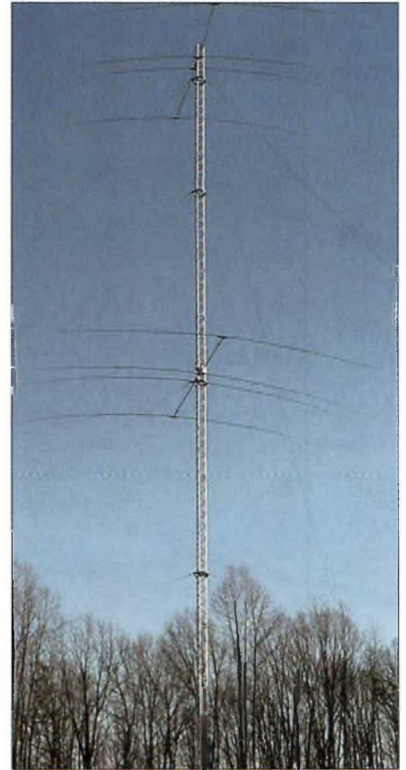
▲ 2 Beam 40m sur pylône de 40m, avant
