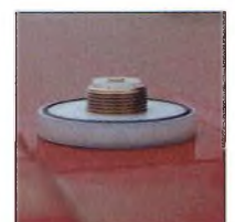
Le support d'antenne fixé sur le toit.
