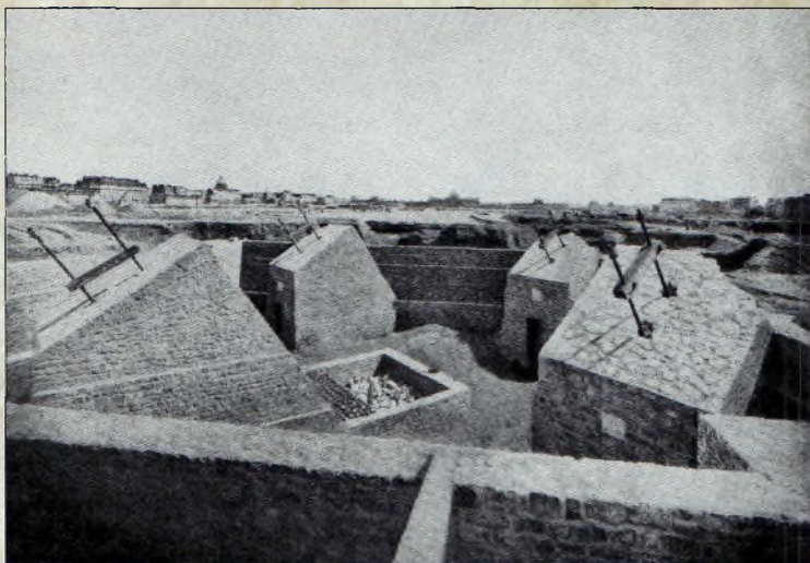
Maçonnerie des fondations avec les boulons destinés à recevoir les piliers
