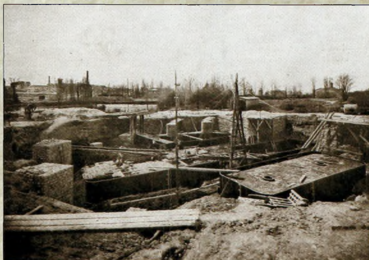
La construction des piliers
