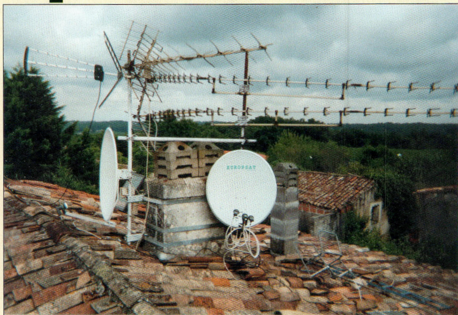
▲ Sur les toits de Cénac (près de BORDEAUX), les paraboles voisinent avec des grandes Yagis pour le DX qui vont bientôt reprendre du service pour la TV numérique terrestre.
