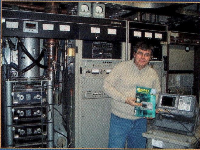
▲ VE2OSK devant un émetteur klystron de 55 Kw
