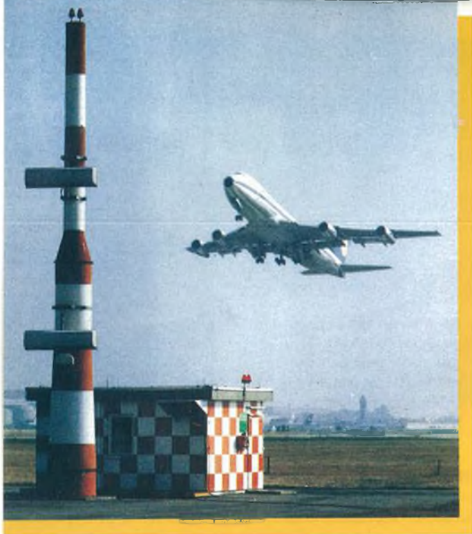
Il trasmettitore del radiosentiero di planata fornisce le informazioni relative al corretto angolo di atterraggio.
