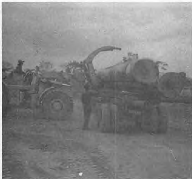
Déchargement d'un grumier avec l'engin à fourche.
