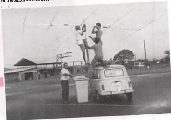
Montage acrobatique d'une beam avec appui sur poubelle et rétablissement sur toit de 4L...
