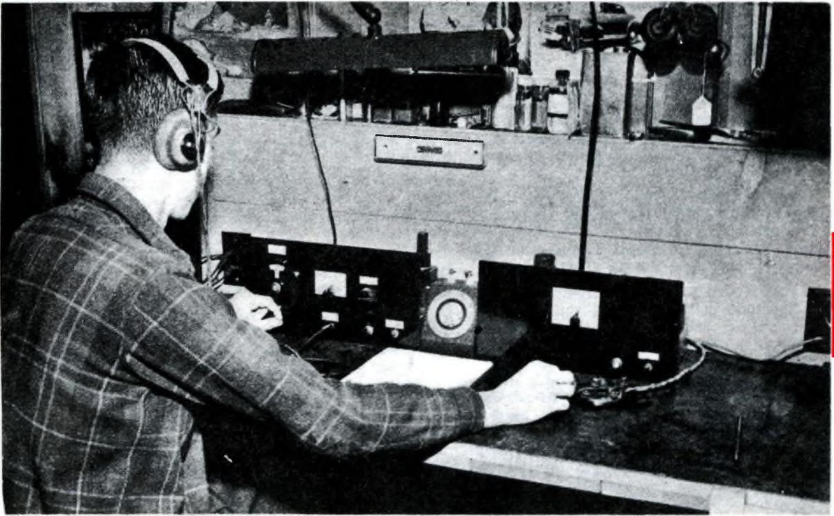
ad arrivare anche a 100 e più chilometri di distanza. La frequenza di trasmissione è stata scelta sulla gamma radiantistica dei 40 metri.
