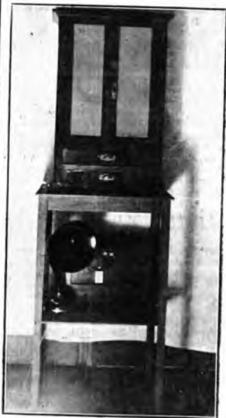
Apparecchio radioricevente costruito completamente ed in modo originale dal nostro abbonato Giovanni Travi di Roma. Il circuito è un C 119 a 5 valvole.
