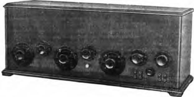
APPARECCHIO tipo R 14 per aereo con due stadi equilibrati di amplificazione in alta frequenza per la ricezione delle radio diffuzioni europee da metri 200 a 2000 in altoparlante anche durante il funzionamento di stazioni locali.
