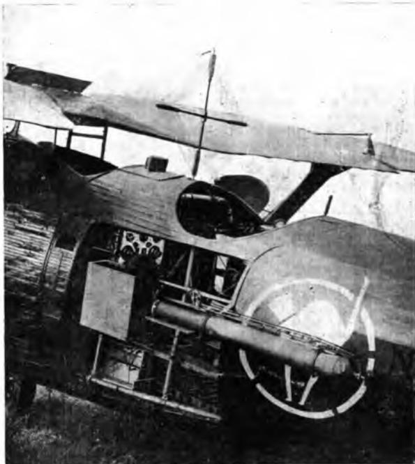
Bréguet Lorraine di 450 HP, era munito di un piccolo telaio di 50 centimetri di lato montato sulla parte superiore della carlinga e unito a una «*Superheterodyne*» degli stabilimenti Radio L.L. di Parigi, modello perfettamente di serie.
