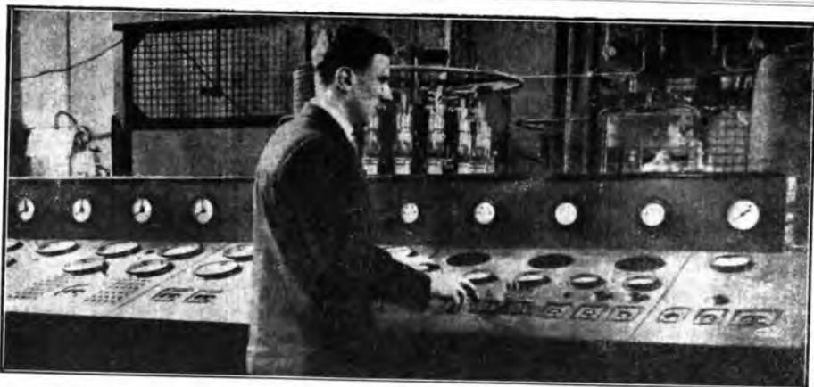
Il nuovo servizio Radiotelefonico Transatlantico. — Il pannello di controllo della Radiostazione di Fittimorton presso Rugby. Il trasmettitore telefonico è situato in un lato della sala apparati dove sono installati anche gli apparecchi trasmettenti radiotelegrafici.
