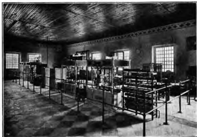
Pannelli - Da sinistra a destra: oscillatore indipendente - rettificatore - oscillatore di potenza - modulatore
