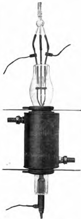
Fig. 62. - Triodo generatore di grande potenza (30 Kw.).
