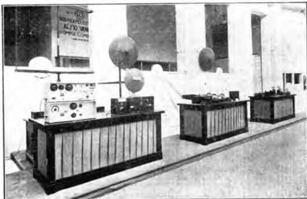
Apparecchio per la misura del campo elettrico, ricevitore a supereterodina ed altoparlanti a doppio cono.
