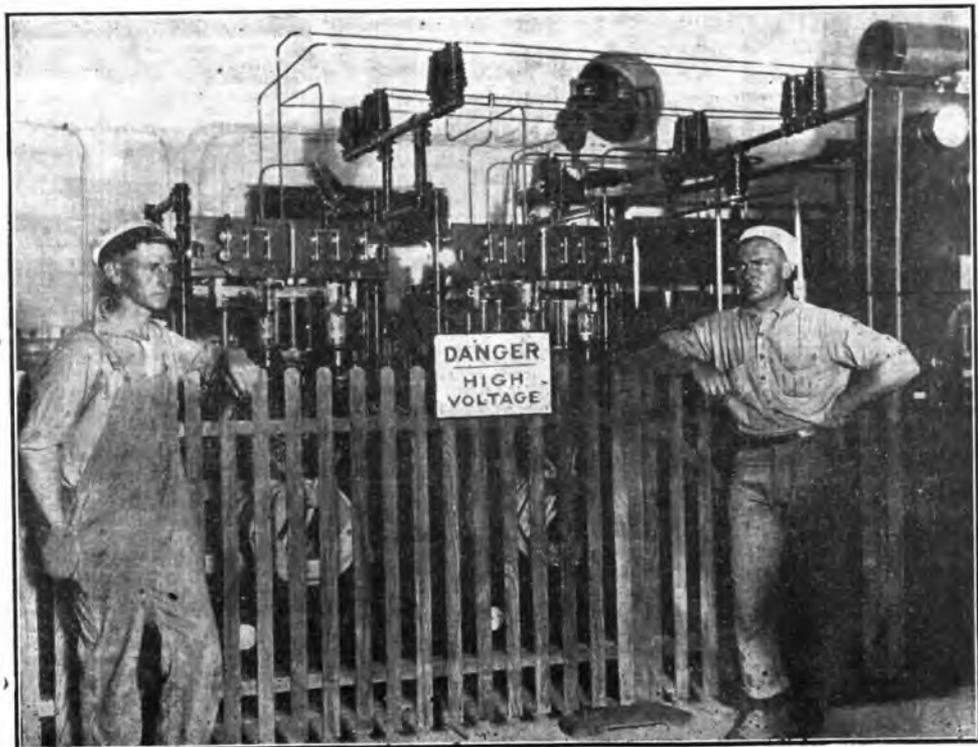
Complesso di quattro valvole trasmettenti da 20 Kw ciascuna, che hanno sostituito un generatore ad arco da 200 Kw
