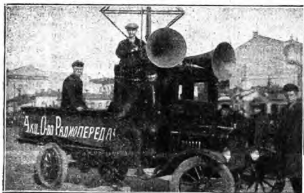
Stazione ricevente munita di potenti altoparlanti montata su autocarro per la propaganda radiofonica
