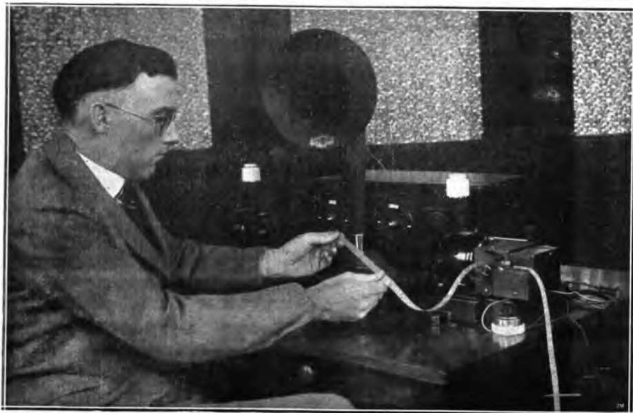
Gli Stati Uniti hanno organizzato un servizio d'informazioni meteorologiche per gli aeroplani. I segnali dell'Ufficio Centrale Meteorologico sono ricevuti automaticamente e poi ritrasmessi agli aviatori.
