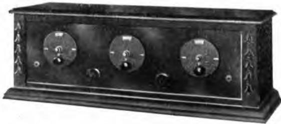
L'apparecchio «Megadina» presenta quindi i seguenti vantaggi: assoluta facilità di manovra, enorme sensibilità, tanto da poter funzionare in forte altoparlante dalle stazioni europee con piccola antenna interna; perfetta selettività, essendo neutralizzato e con reazione elettrostatica; riproduzione dei suoni con perfetta melodia e purezza, grazie alla doppia amplificazione a resistenza-capacità.
