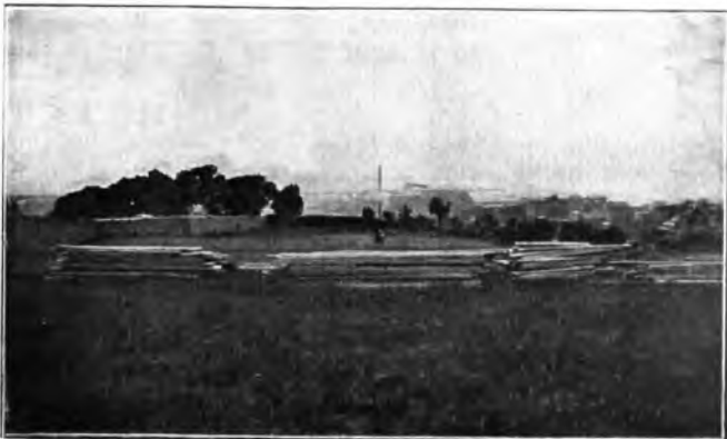
L'inizio dei lavori
