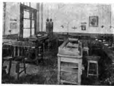
Sede Centrale di Milano - Dettagli. Officina
