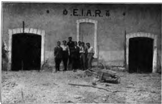
Un gruppo di tecnici che si prodigarono alacremente pel montaggio della stazione
