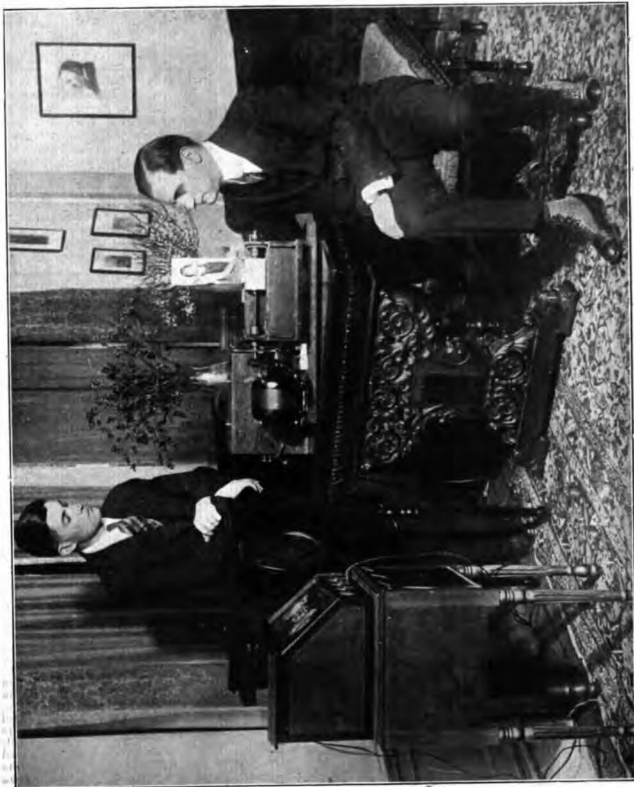
Ecco un altro semplice e praticissimo apparecchio recentemente creato dal dott. Alexanderson della General Electric Co., che collegato ad un normale radiorelettore al posto dell'altoparlante, consente la ricezione rapida di fotografie, schizzi, autografi, ecc., trasmessi dalla stazione radiodiffonditrice. Nella fotografia si vede il dott. Goldsmith che sta osservando un'immagine appena ricevuta
