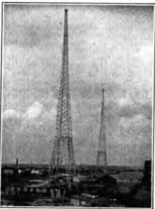
Le torri della stazione di Loksted b. Hamburg
