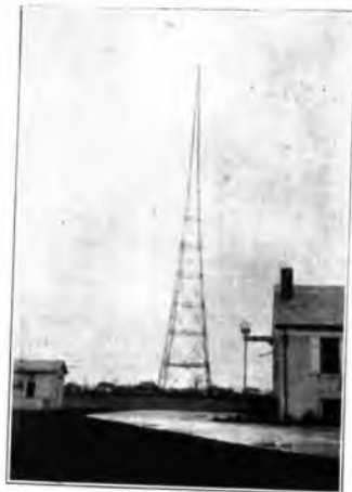
La stazione di Bellmore (New-York), a destra l'edificio della stazione, a sinistra la cabina d'accordo.
