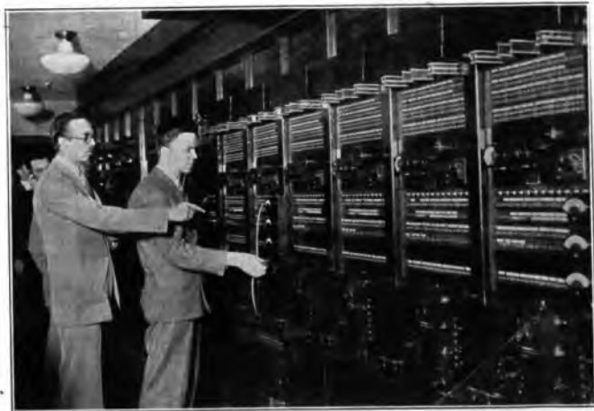
Il locale di controllo centrale delle stazioni della N. B. C.
