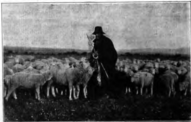
La suggestiva campagna romana nei pressi di S. Palomba prima dei lavori dell'EIAR
