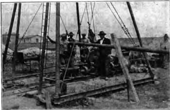
Fig. 3 - Perforazione del suolo per l'impianto di presa d'acqua (profondità m. 68)
