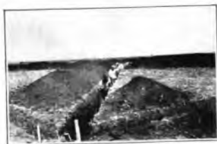
Sanita Palomba (Roma) Scavi per la posa del sistema di terra
