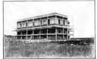
Fig. 4 Santa Palomba (Roma) Edificio per il trasmettitore (Stato lavori al 10 agosto)
