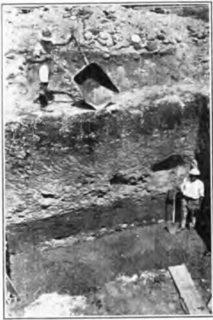
Santa Palomba (Roma) Scavo per i blocchi di fondazione della torre
