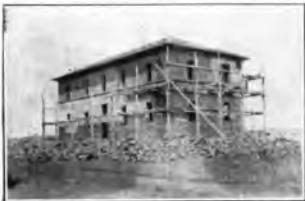
Fig. 6 Santa Palomba (Roma) Casa per le abitazioni del personale (Stato lavori al 10 agosto)
