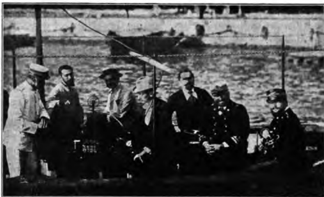
Primi esperimenti di Marconi: La Spezia, luglio 1897 - Stazione ricevente installata sul R. Rimorchiatore N. 8
