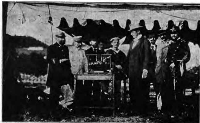
Primi esperimenti di Marconi: La Spezia, luglio 1897 - Stazione trasmettente installata a terra a S. Bartolomeo
