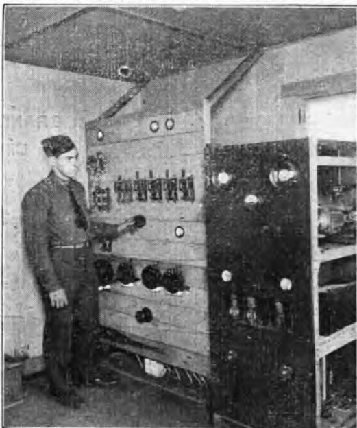
Il tenente Benjamin Kelsey vicino alla trasmittente di un Kw. che lo guida, nel suo recente volo alla cieca, sano e salvo fino all'atterraggio. La trasmittente funziona premendo un solo bottone.
